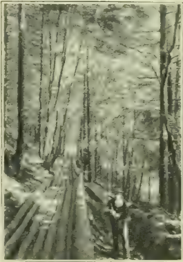
FIG. 136. — UNE RISE POUR LA DESCENTE DES BOIS DANS LES ALPES.
